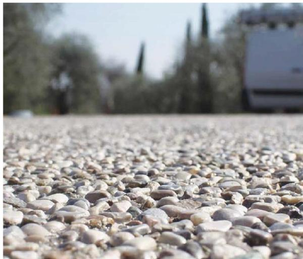
Figura 17: Esempio di pavimentazione in calcestruzzo architettonico drenante
