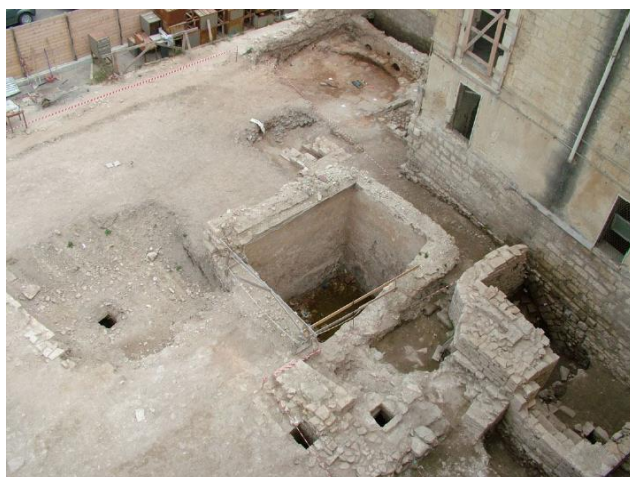
Veduta generale dell’area di cantiere nella fase di ultimazione dei lavori, immagine estratta dalla R.I.A. (Cfr. Infra, nota n. 5, fig. 18)
