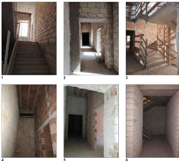
Stato attuale dell'immobile, immagini estratte dal Progetto di fattibilità tecnica ed economica allegato alla procedura di gara (Tav. n.8 – Rilievo fotografico stato di fatto piani primo e secondo)
