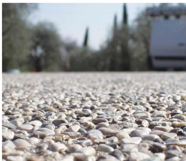
Figura 17: Esempio di pavimentazione in calcestruzzo architettonico drenante
