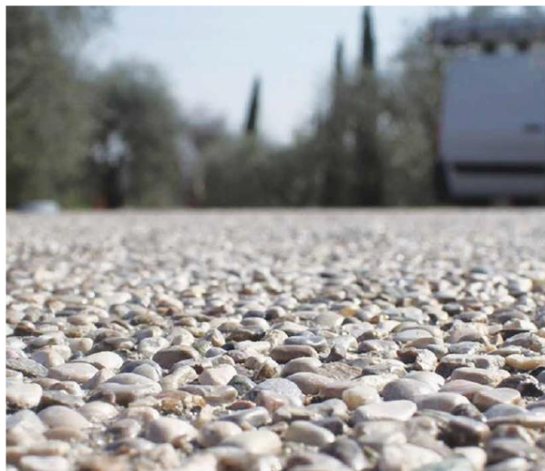
Figura 17: Esempio di pavimentazione in calcestruzzo architettonico drenante
