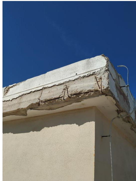
Figura 15 Esterno centrale termica
