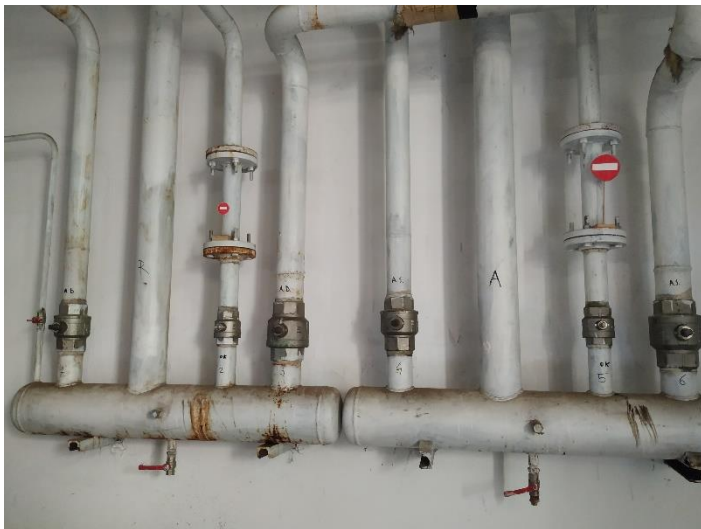
Figura 18 Collettore di distribuzione scuola media G.Bovio
