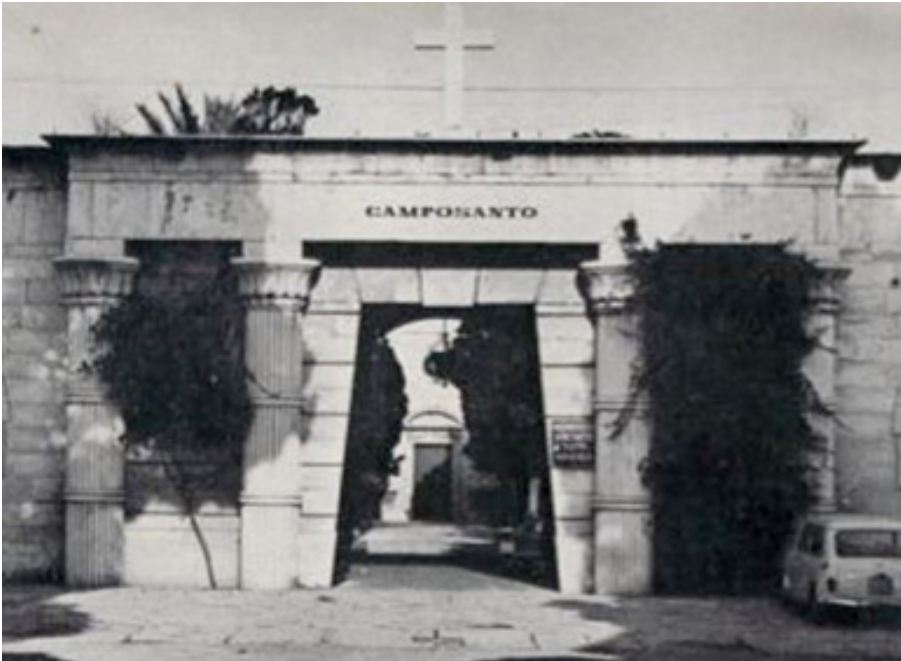
Particolare del prospetto principale originario
