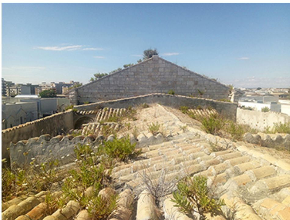
Copertura della Chiesa
