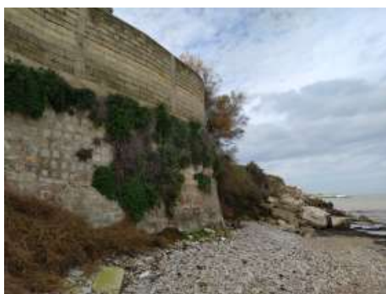
muro di sostegno con spiaggia
