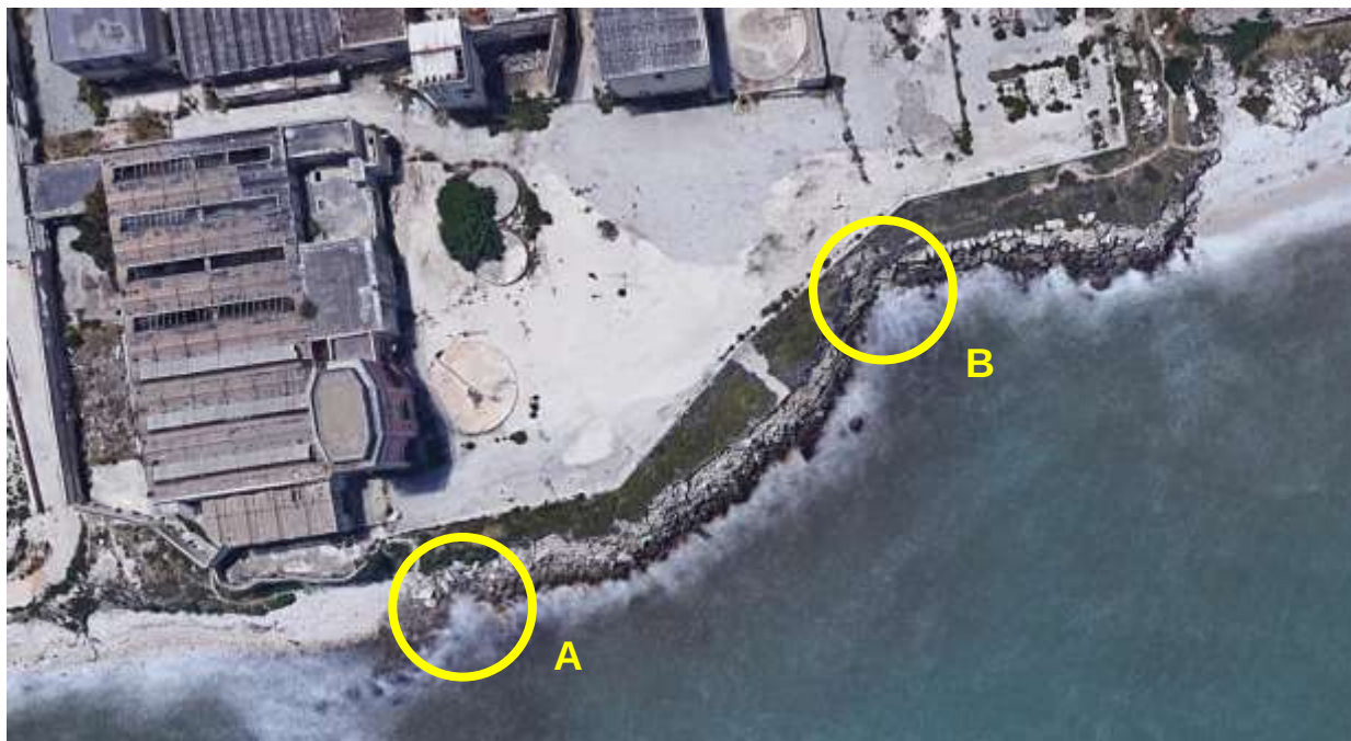
Fig. 46 – Tratti di versante da ripristinare
