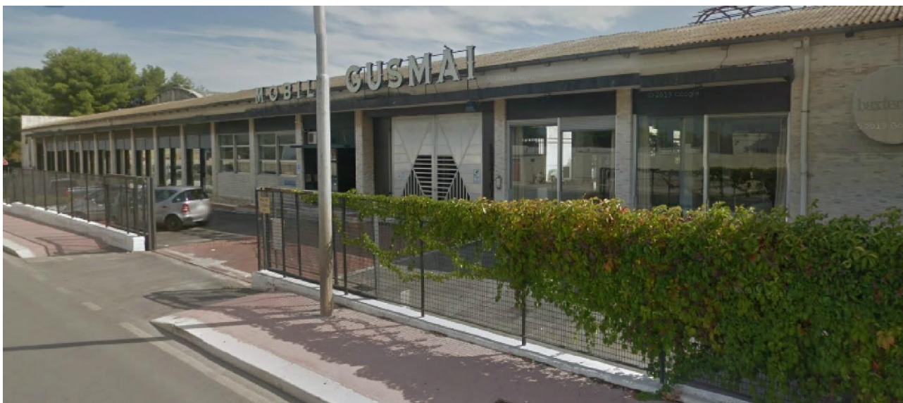
Edificio produttivo dismesso
