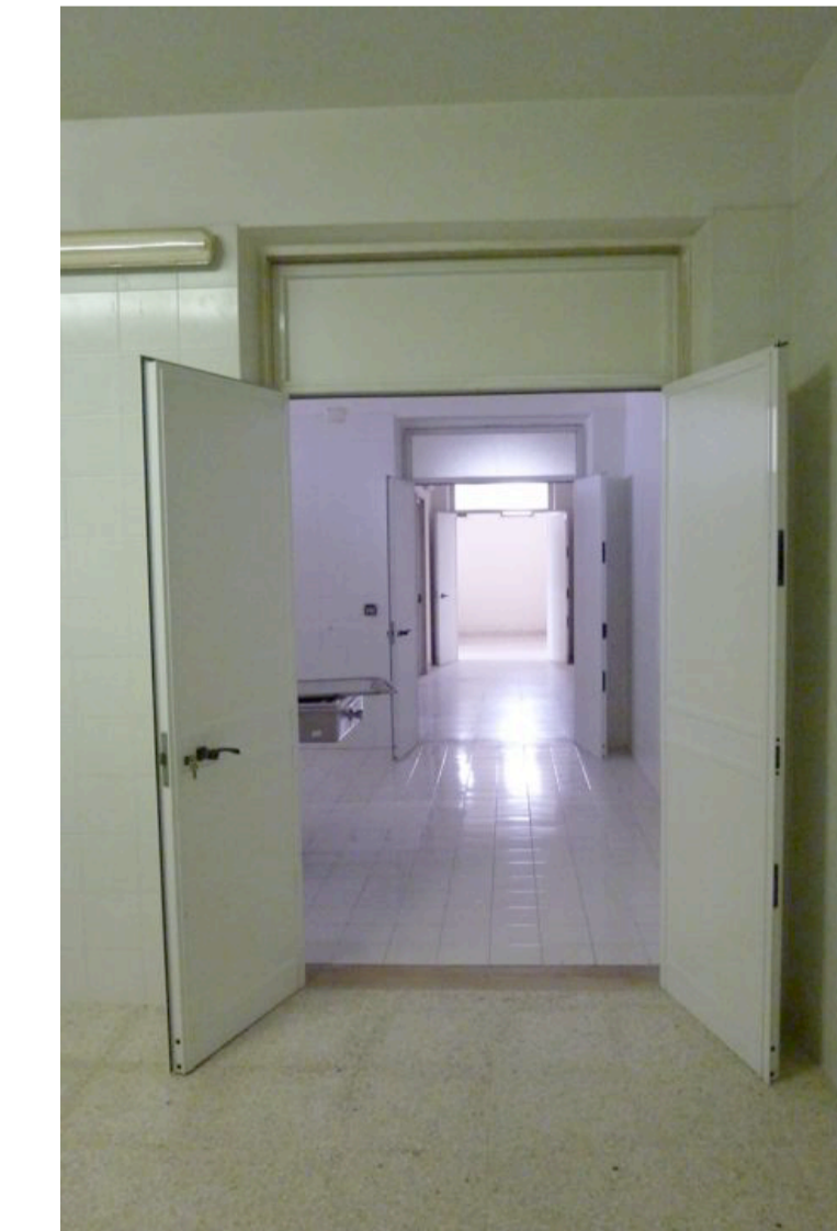
Corridoio di disimpegno
