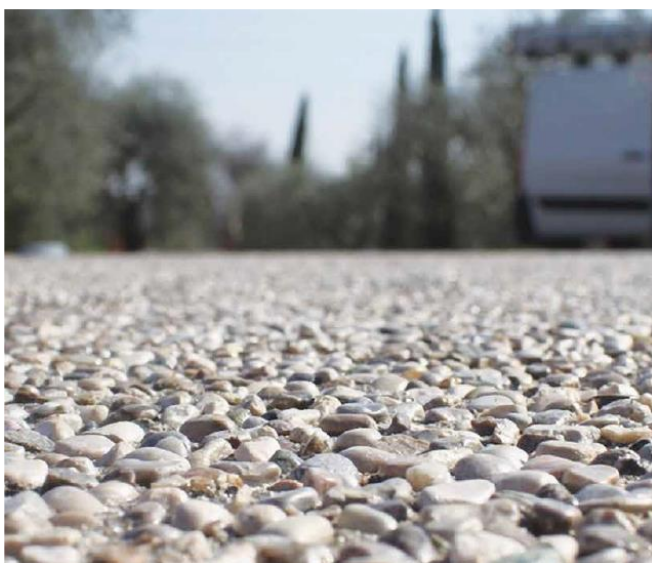
Figura 14: Esempio di pavimentazione in calcestruzzo architettonico drenante
