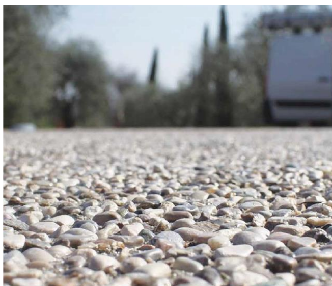
Figura 14: Esempio di pavimentazione in calcestruzzo architettonico drenante
