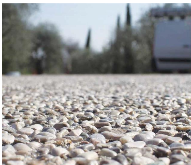
Figura 15: Esempio di pavimentazione in calcestruzzo architettonico drenante
