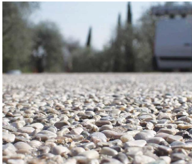
Figura 15: Esempio di pavimentazione in calcestruzzo architettonico drenante
