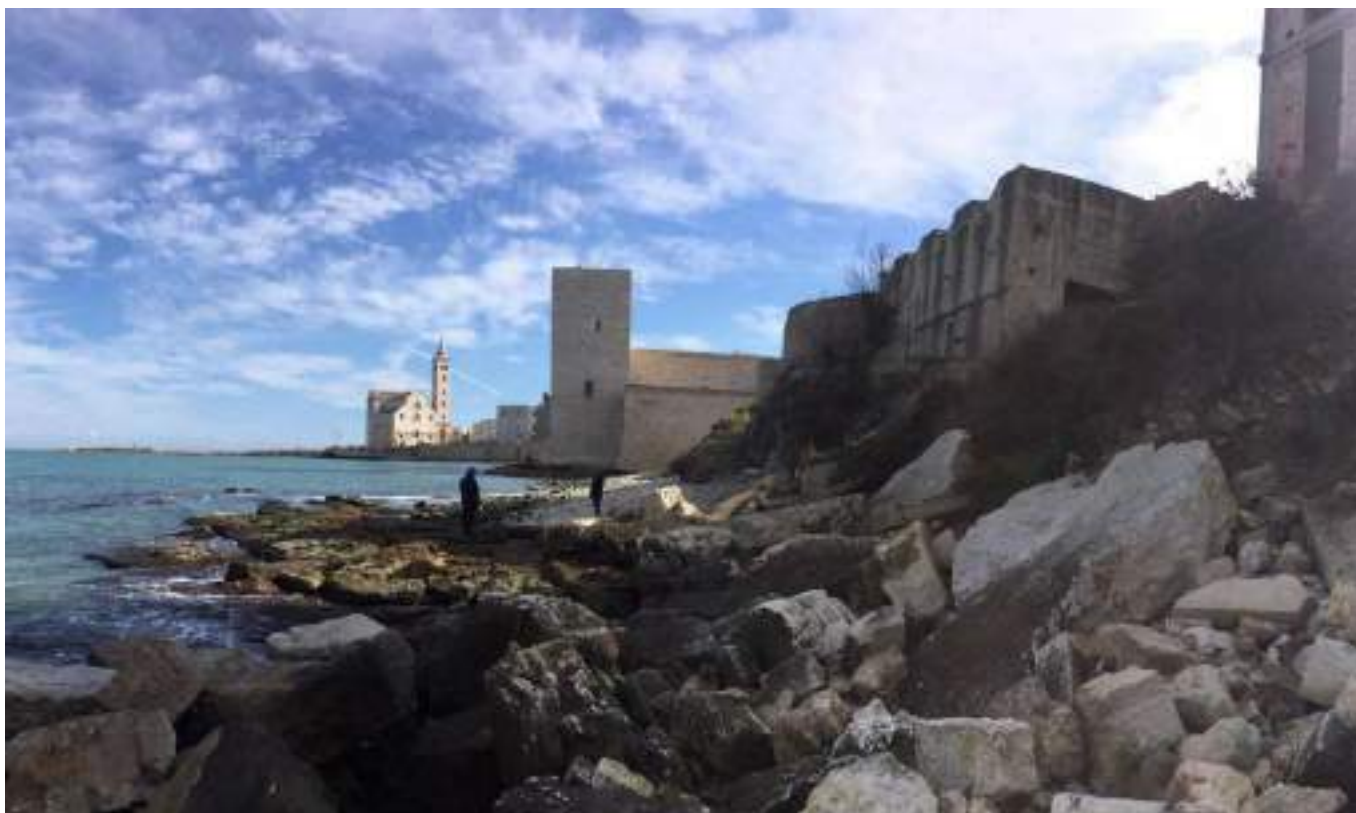
Stato di attuale degrado della costa.
