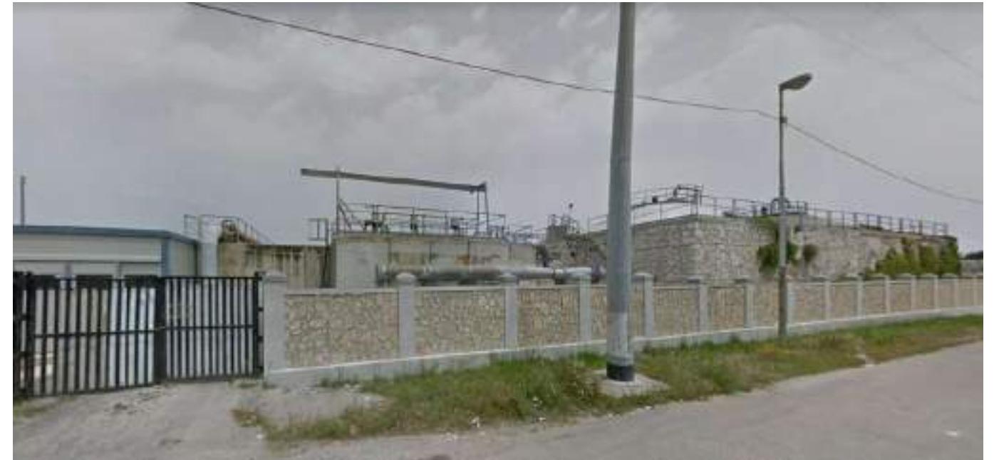
Foto esterna dell'impianto di depurazione, su cui sono previsti interventi di mitigazione.
