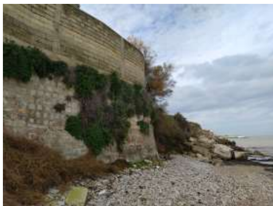
muro di sostegno con spiaggia
