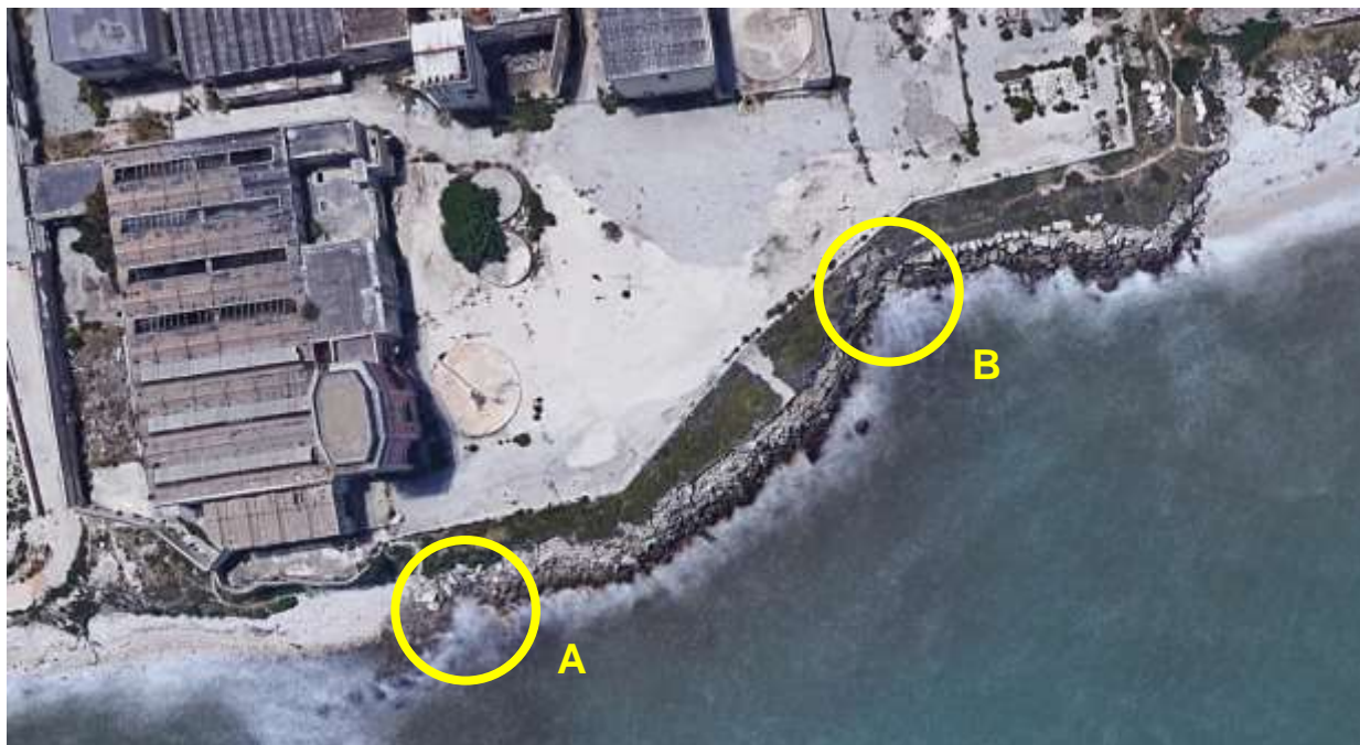
Fig. 46 – Tratti di versante da ripristinare
