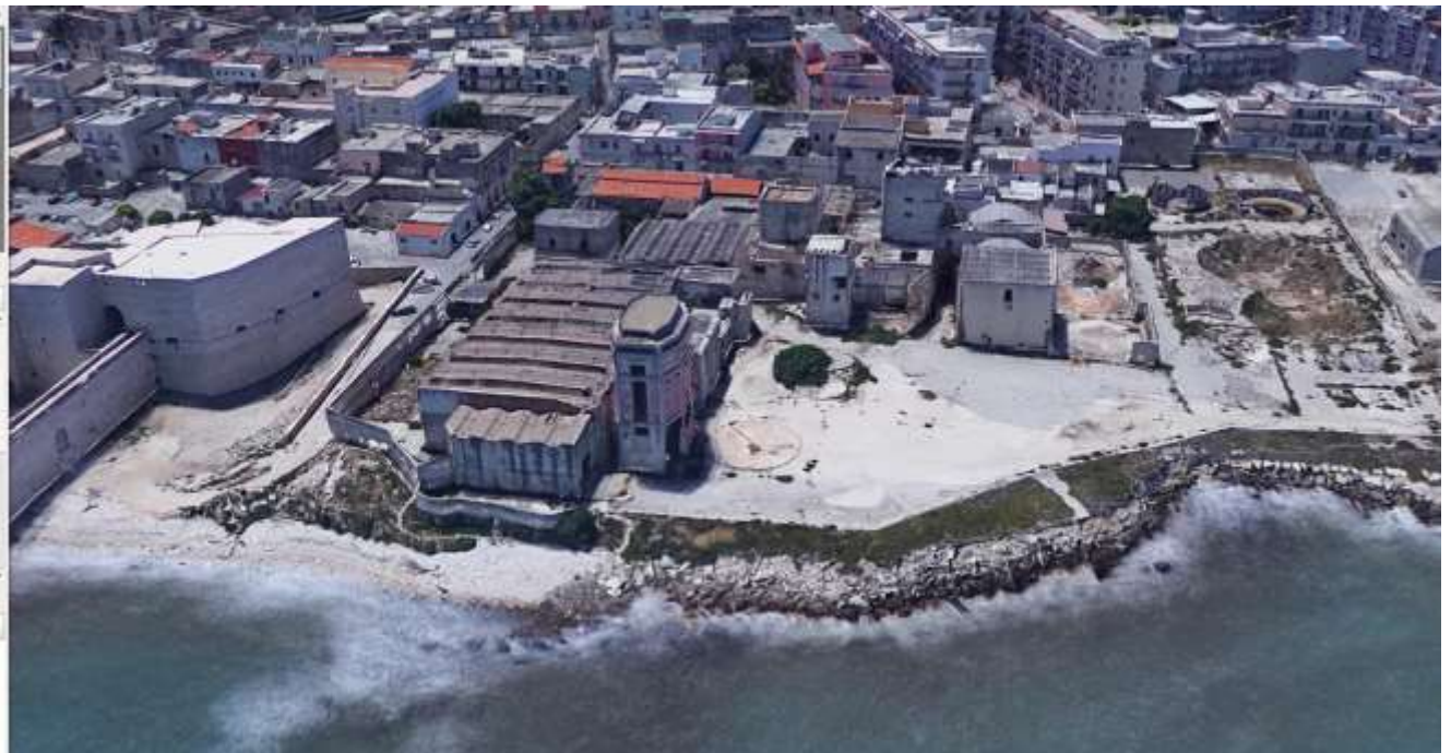
Fig. 14 – Vista aerea della zona interessata dalla pericolosità geomorfologica
