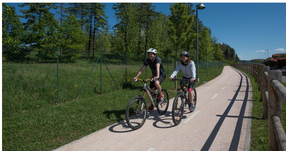
Figura 14: Esempio di pavimentazione in calcestruzzo architettonico drenante ciclabile
