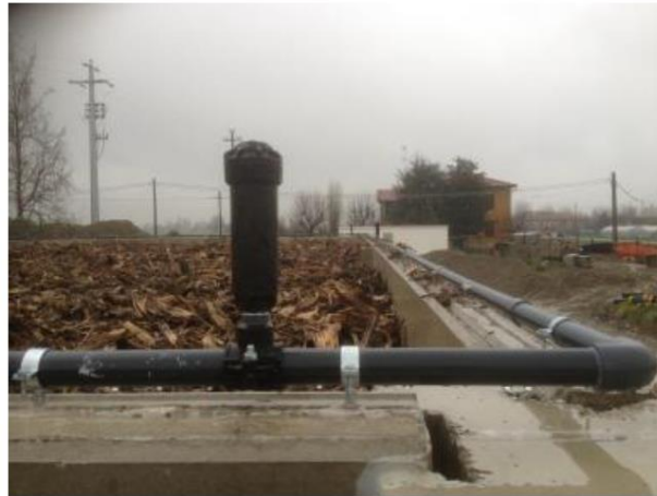
Figura 5: sistema di irrigazione biofiltro
