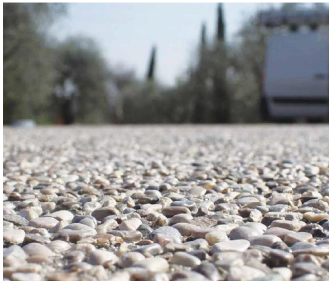
Figura 15: Esempio di pavimentazione in calcestruzzo architettonico drenante
